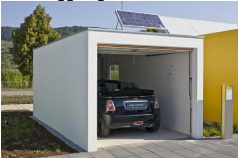
Fertigaragen mit Flachdach mit extensiver Begrünung auf frostsicheren Streifenfundamenten, Größe 2,98 m x 6,00 m. (Einzelgarage)
