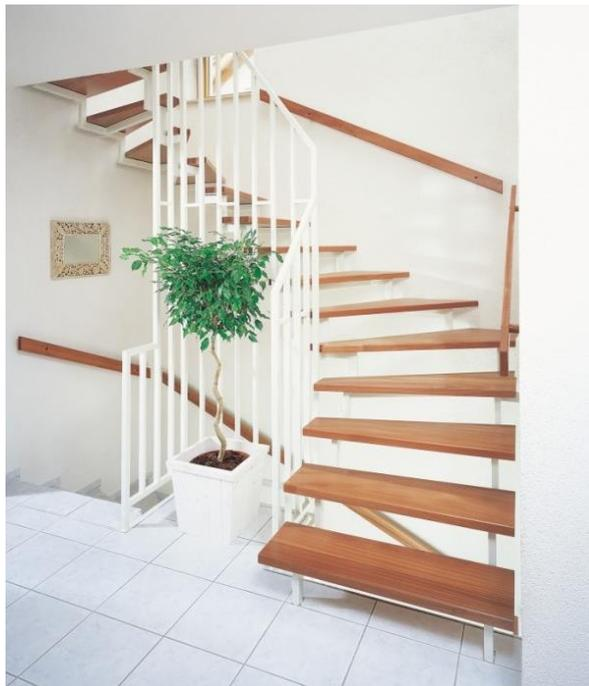
Das Gebäude erhält Stahltreppen mit Metallharfengeländer und Hartholzbelag in Buche stabverleimt
